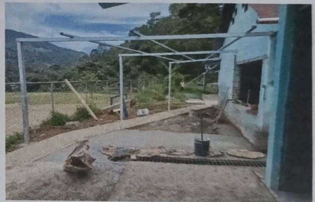
Foto 4: MEJORAMIENTO DE TECHO
