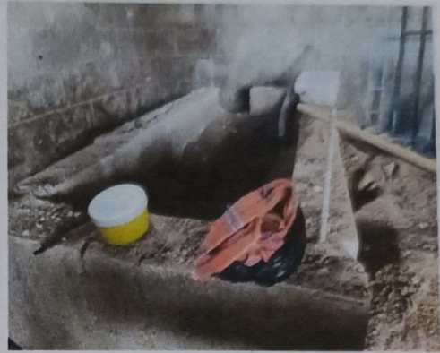
Foto 2: mejoramiento de la cocina
