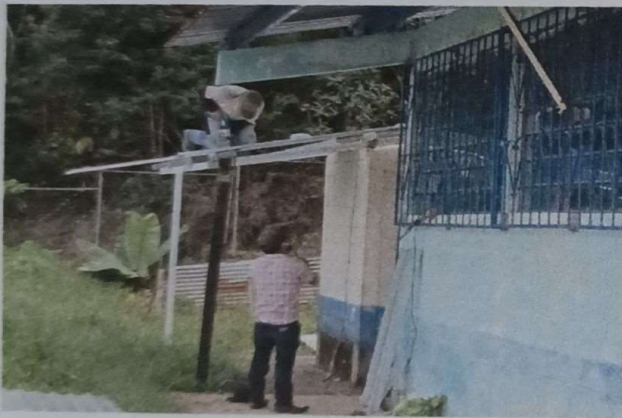
Foto 3: MEJORAMIENTO DE SANITARIO
